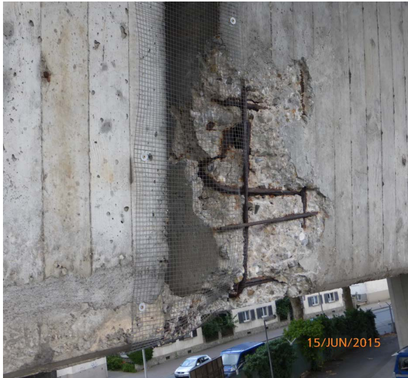
Schäden am Endquerträger
