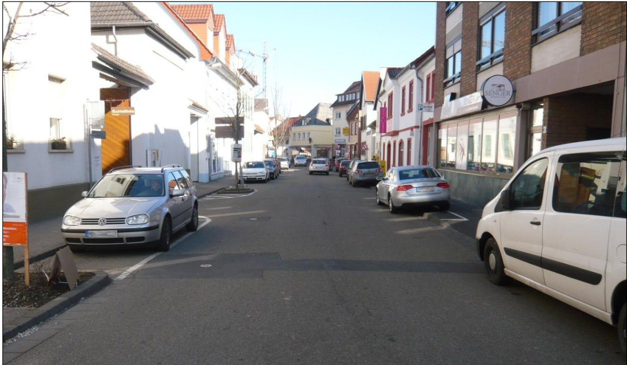
Bild 22: Engstelle Ortskern Hechtsheim, Alte Mainzer Straße
