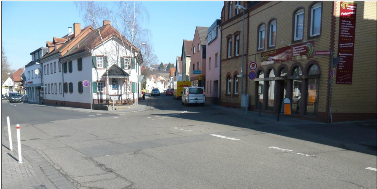
Bild 24: Knotenpunkt Alte Mainzer Straße/ Neue Mainzer Straße
