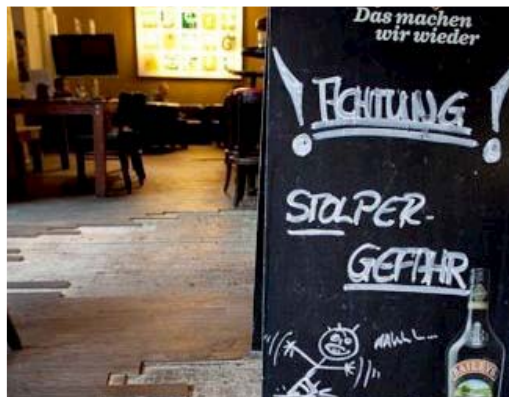
Cafe Codex, Boden in schlechtem Zustand
