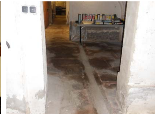
UG Römischer Kaiser, Feuchtigkeitsprobleme
