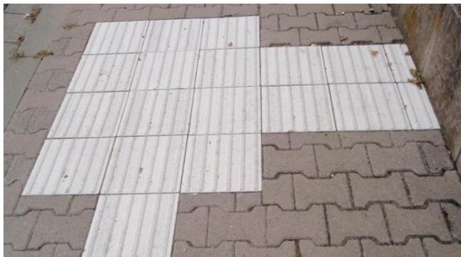
**Bild:** Taktile Auffindestreifen mit Bus-Einstiegsfeld und Leitlinie an einer Haltestelle
