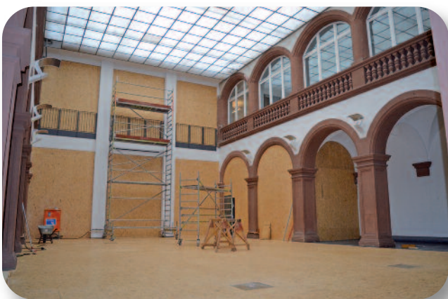
Vorbereitung des Lichthofs für den Umbau
