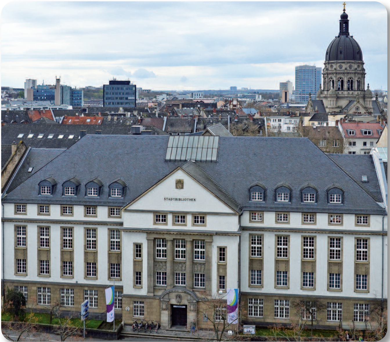
Der Magazintrakt des Stadtarchivs befindet sich im Dachgeschoss des Gebäudes.
