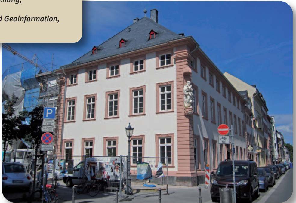
Bauarbeiten in der Altstadt: Neutorstraße 3
