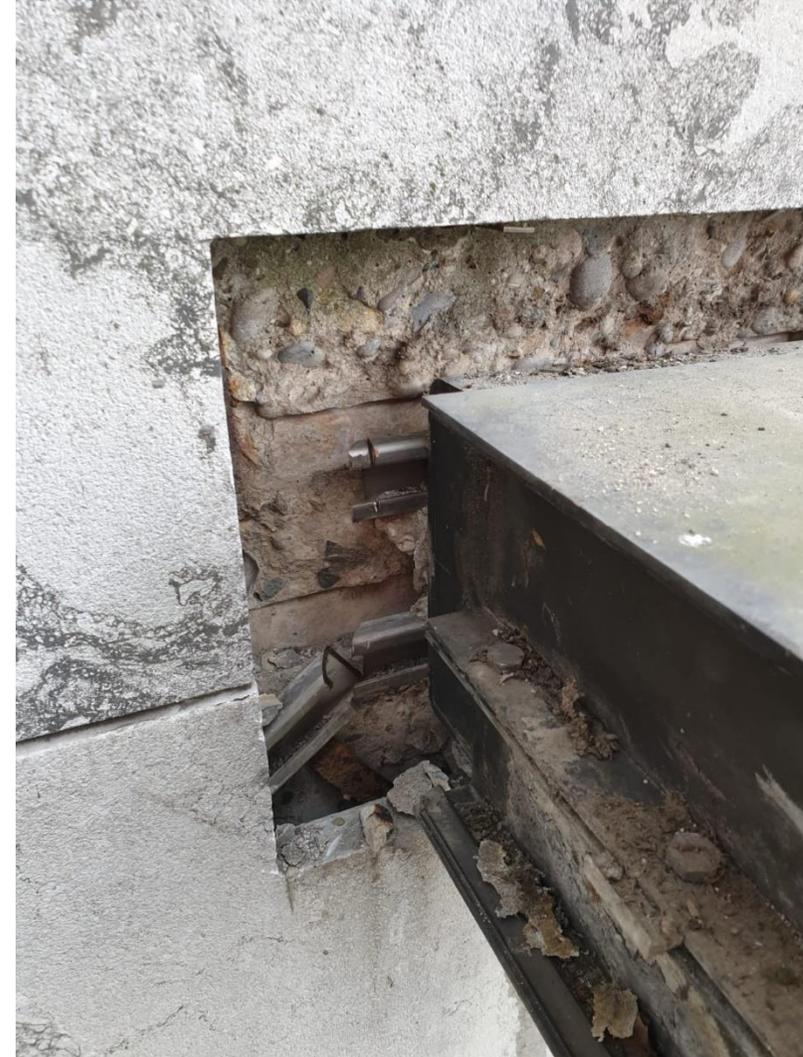
Abb.25: Anschlagpunkt der Riegel an der Betonwand
