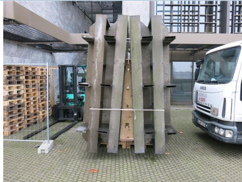
Abb.18: Vier verzurte Gitterelemente auf Stellage
