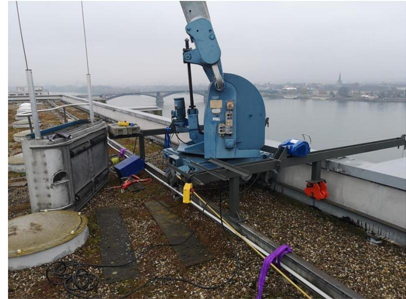
Abb.18: Konstruktion eines Behelf-Transportkrans
