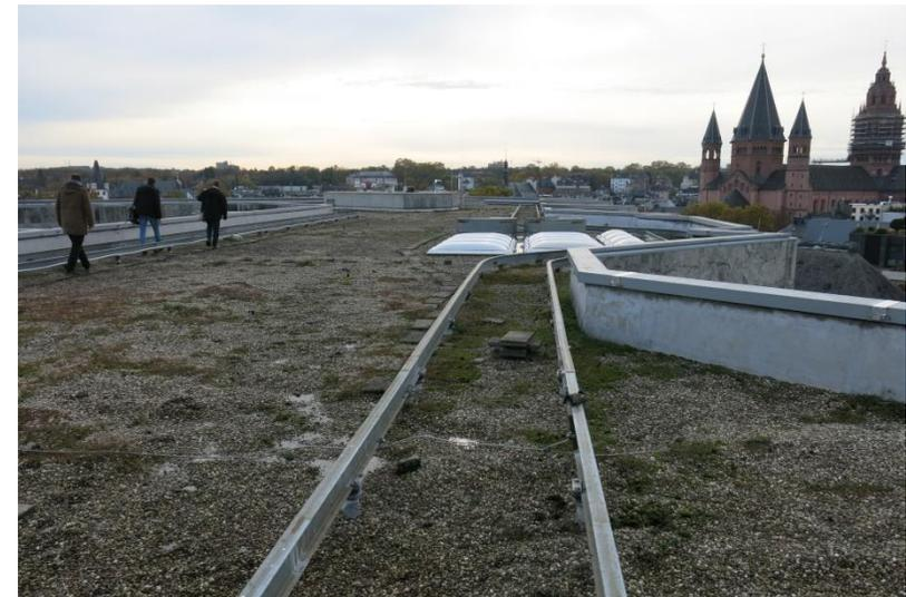
Abb.19: Verlauf des Schienensystems Gebäudereinigung
