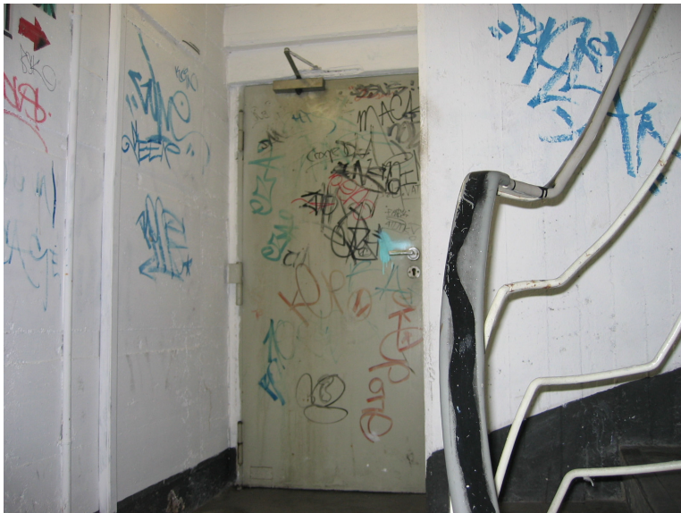
Angstraum: Zugang zum Parkhaus
