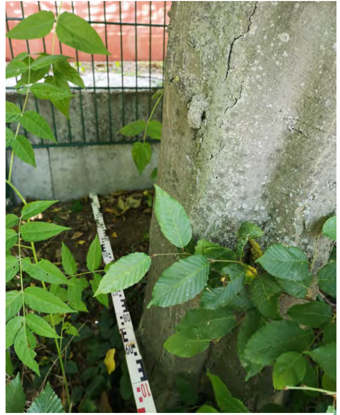
S3, L-Steinmauer verbleibt, Zaun wird abgebaut
