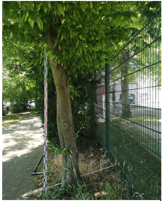
S4, Zaun wird abgebaut
