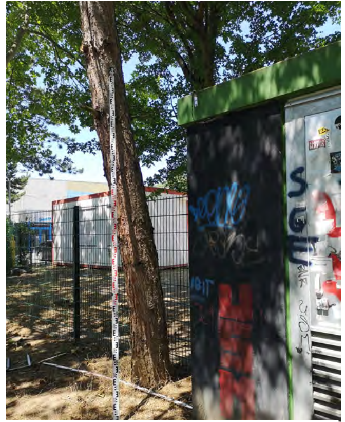
S10, Stabgitterzaun wird abgebaut
