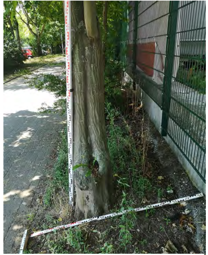
S1, L-Steinmauer verbleibt, Zaun wird abgebaut
