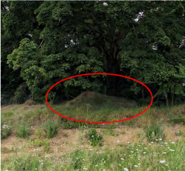
Abbildung 21: Schädlicher Erdhaufen auf dem Wurzelteller des Baums Nr. 89
