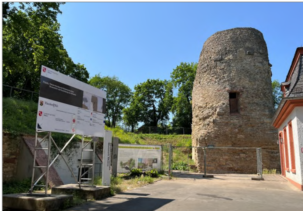
Abbildung 7: Aktueller Sanierungsstand Drususstein.
