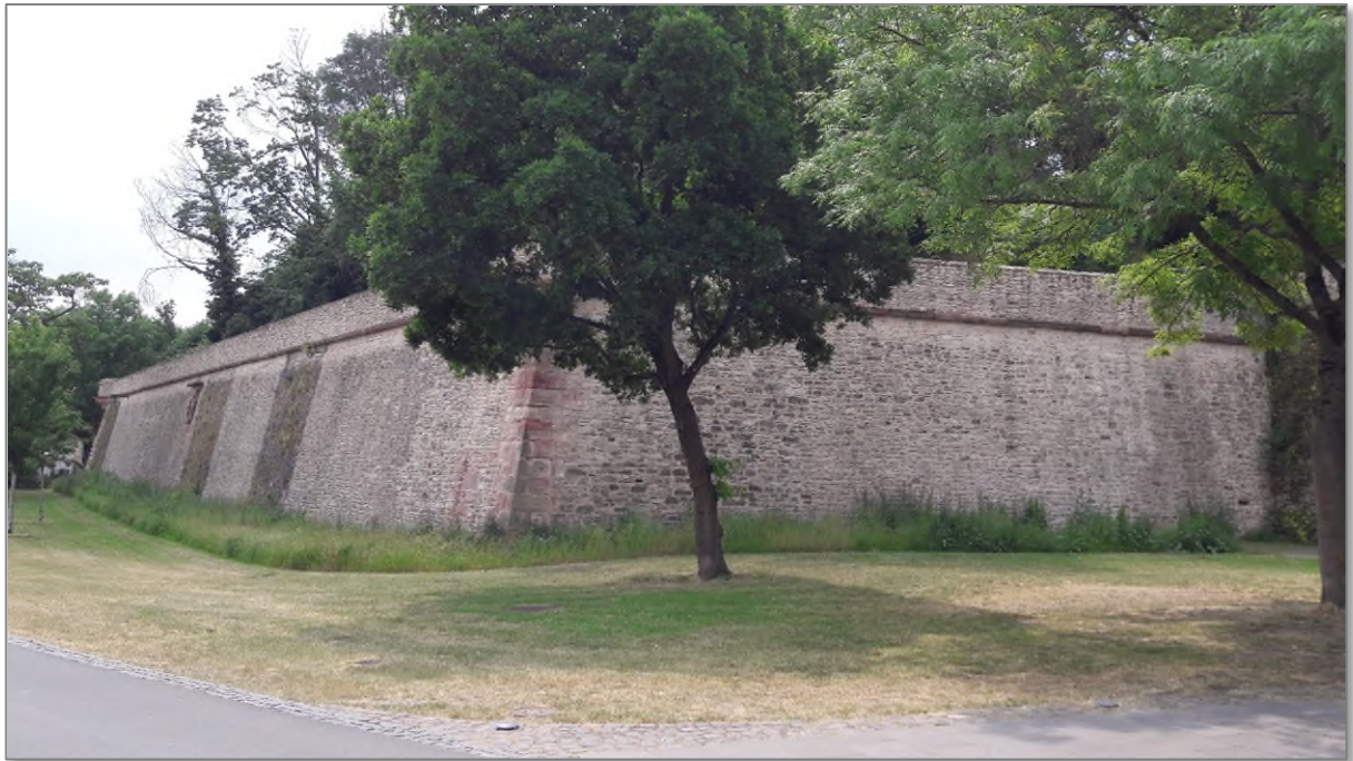
Abbildung 5: Sanierter Abschnitt der Zitadellenmauer.
