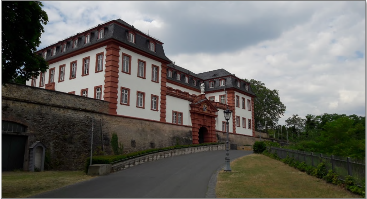
Abbildung 13: Kommandantenbau – Gebäude A.
