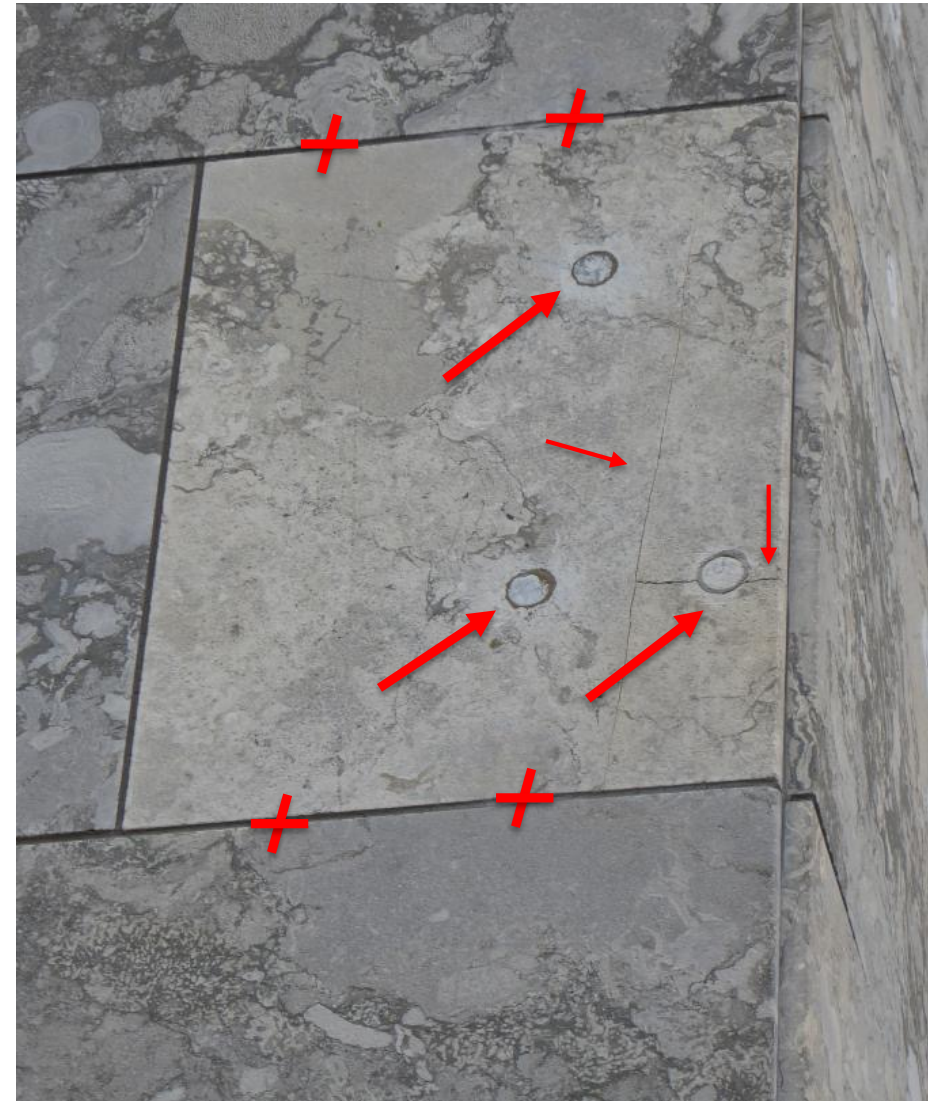
Natursteinplatte mit 4 Ankerdornen - zwei Risse konnten festgestellt werden
