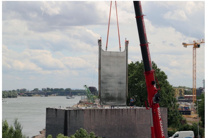
Hochwasserpumpwerk Gaßnerallee: Zur Reparatur musste die 22.000 Kilogramm schwere Wehrplatte aus dem Bauwerk gehoben werden
