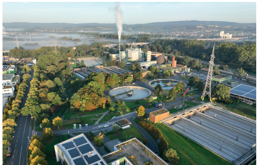
Das Mainzer Zentralklärwerk: Rund 45 Millionen Liter Schmutz- und Niederschlagswasser fließen durch die Kanäle der Landeshauptstadt in die Anlage - und zwar täglich!
