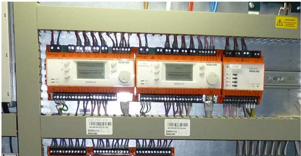
Beispiel 3: Controller im Schaltschrank .
