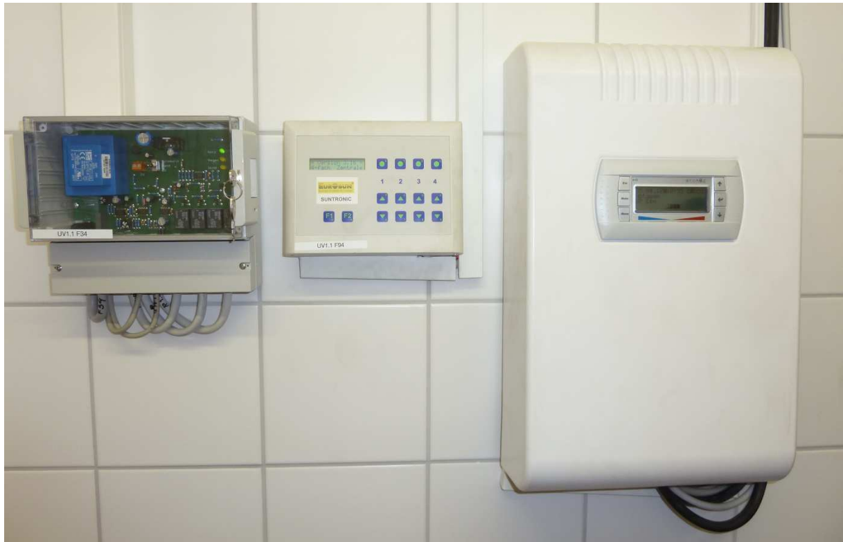
Beispiel 2: Umgesetzte dezentrale Regelung einer Wärmepumpe .
