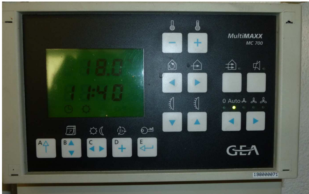
Beispiel 4: Umgesetzte dezentrale Regelung einer Wärmeerzeugungsanlage .
