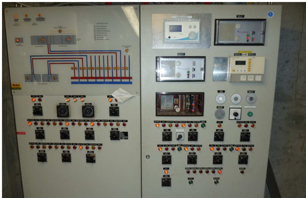
Beispiel 5: Umgesetzte (sehr alte/ abgängige) zentrale Regelung einer Wärmeerzeugungsanlage .
