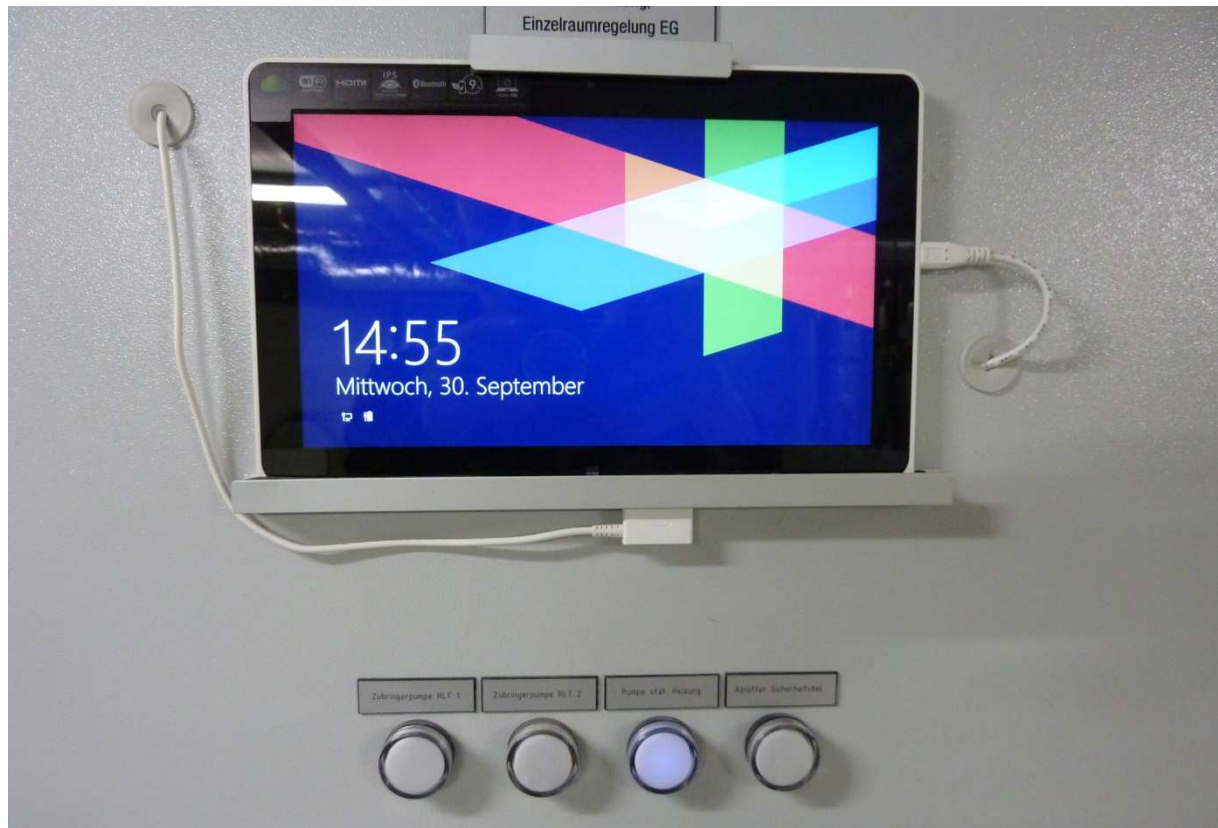
Beispiel 6: Umgesetzte dezentrale Regelung in einem Neubau ohne Auflegung auf MBE, hier Display .
